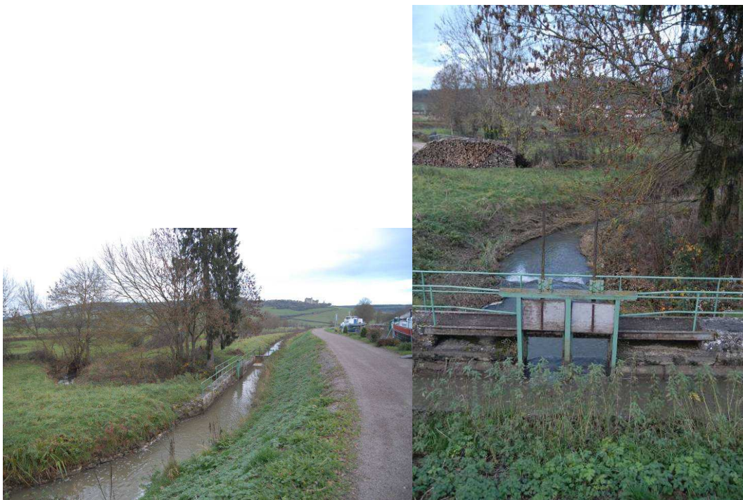
Image 3 : dérivations de cours d'eau en tête de bassin pour alimenter le canal de Bourgogne.
